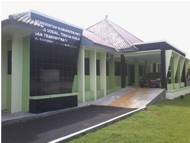
Gbr.17 Gedung Pusat Administrasi
