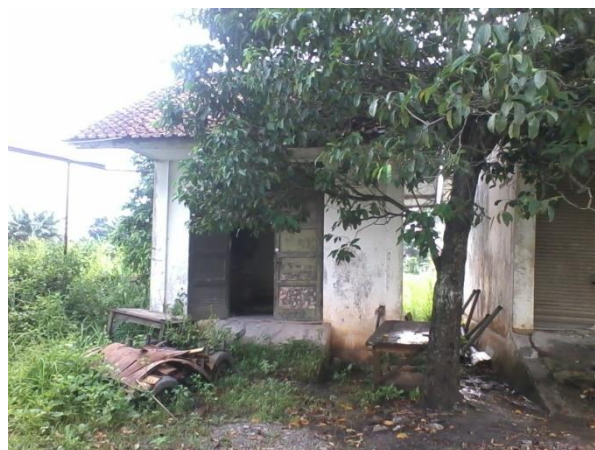
Gbr. 8 Ruang Panel Listrik dari Luar
