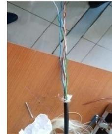
Gambar 9. Pengupasan Kabel Distribusi
