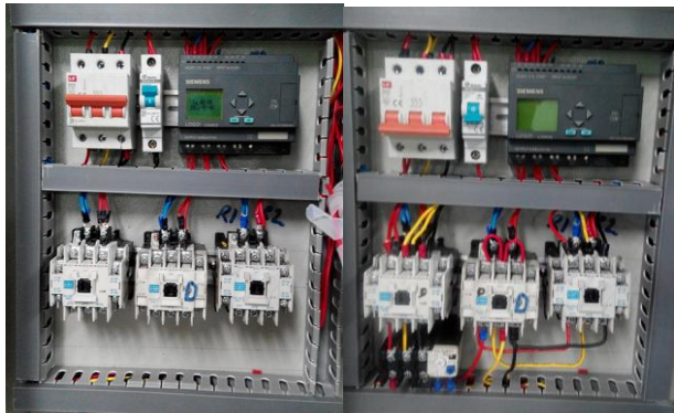
Gambar 13. Kontrol Kendali Motor Bintang Segitiga Menggunakan SR Siemens LOGO 230RC Sebelum dan Sesudah Dipasang Rangkaian Daya/Tenaga Pada Kontaktor.
