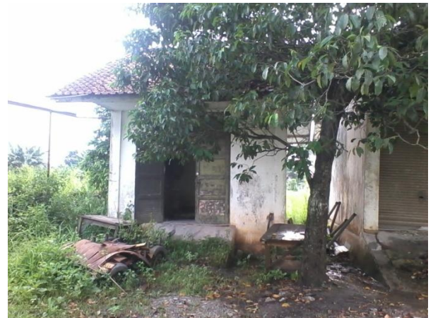
Gbr. 8 Ruang Panel Listrik dari Luar
